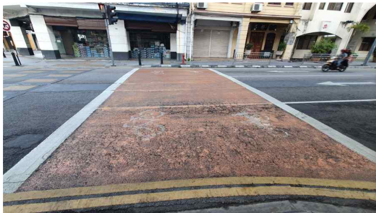
[사진 1] 교차로에 설치된 바이크 박스 (출처: 필자 직접 촬영)
