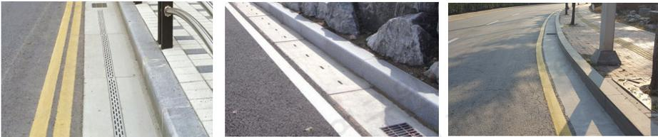
[그림 6-1] 배수 및 표면 처리된 도로측구 예시
