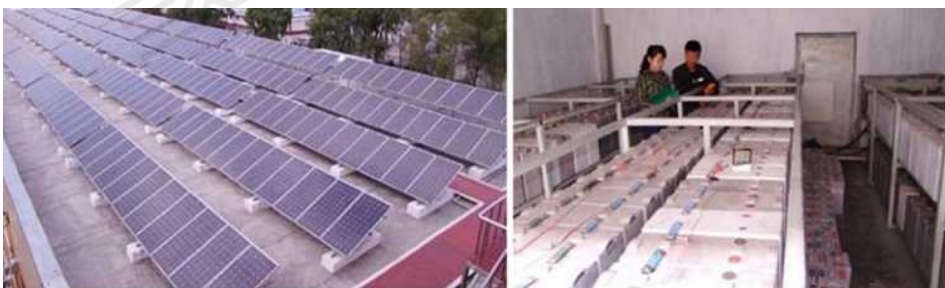
[그림 3-51] 류원신발공장의 400kW 태양광발전 체계
