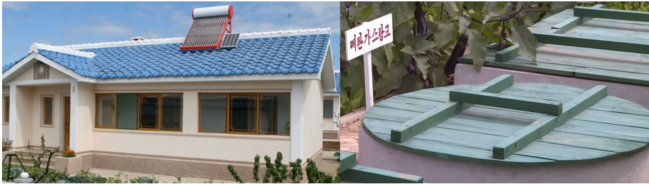
[그림 3-50] 장천남새농장 살림집의 태양열/태양광 설비(좌)와 메탄가스 설비(우)
