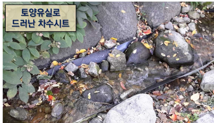
(2) 물길 수변과 하상의 토양유실 상태
