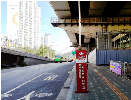
(1) 시설 부지 부근: 자동차 전용도로
