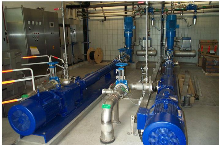
〈그림 3-20〉 독일 Weisbaden 하수처리장에 설치된 수리동력학적 cavitation 발생장치
