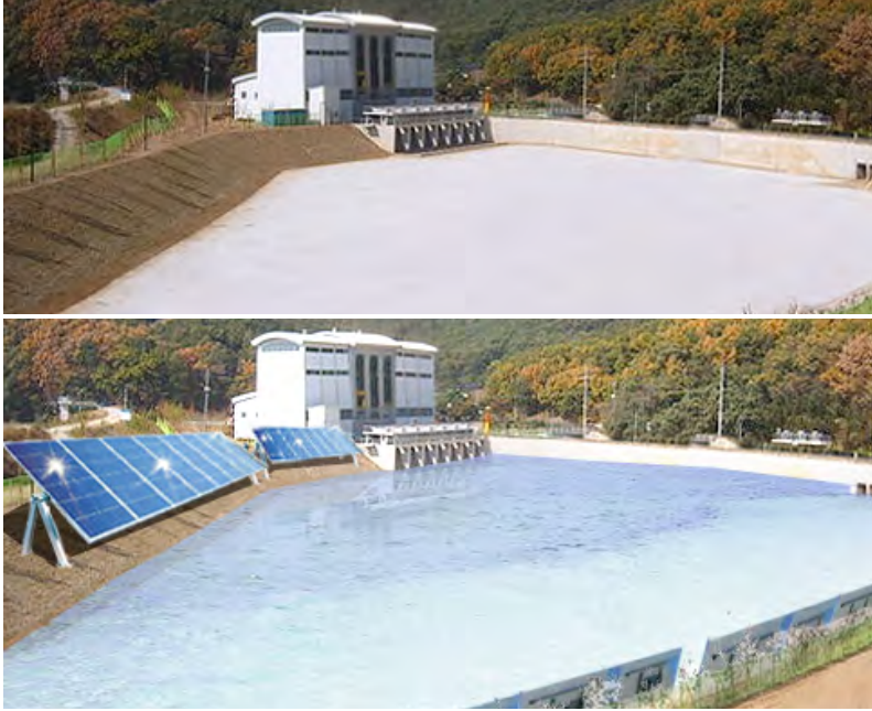
〈그림 4-6〉 유수지 사면의 태양광발전시설 설치 구상
