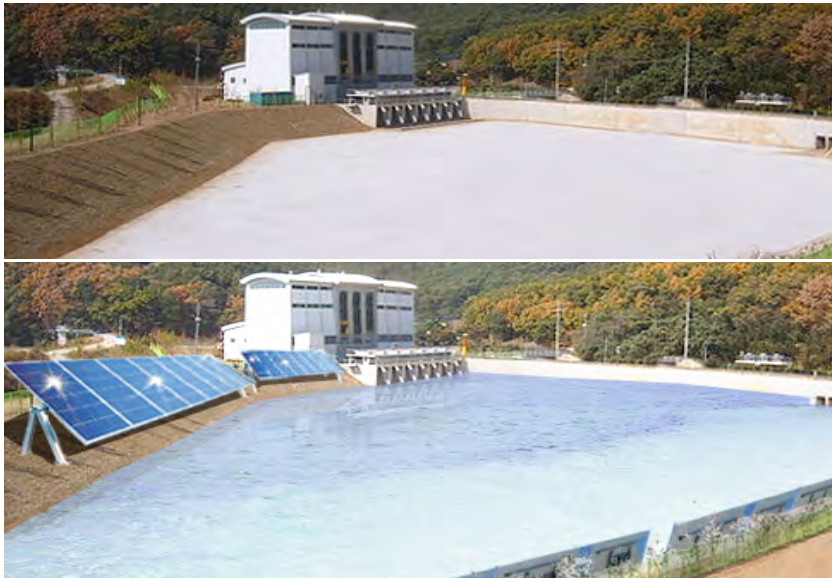
〈그림 2〉 유수지 사면의 태양광발전시설 설치 구상
