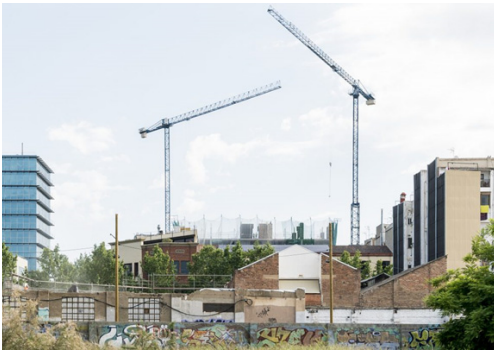
[그림 1] 바르셀로나 신규주택 건설 모습
