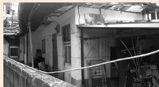
건물 외부전경(철거 전)
