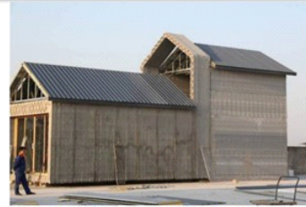
영추양 신소재 주식회사는 지붕을 제외한 건물 전체를 3D 프린터로 출력했다. 공장에서 제조되고 부지에서 조립되는 방식이다 (사진 : 영추양 신소재 주식회사)
