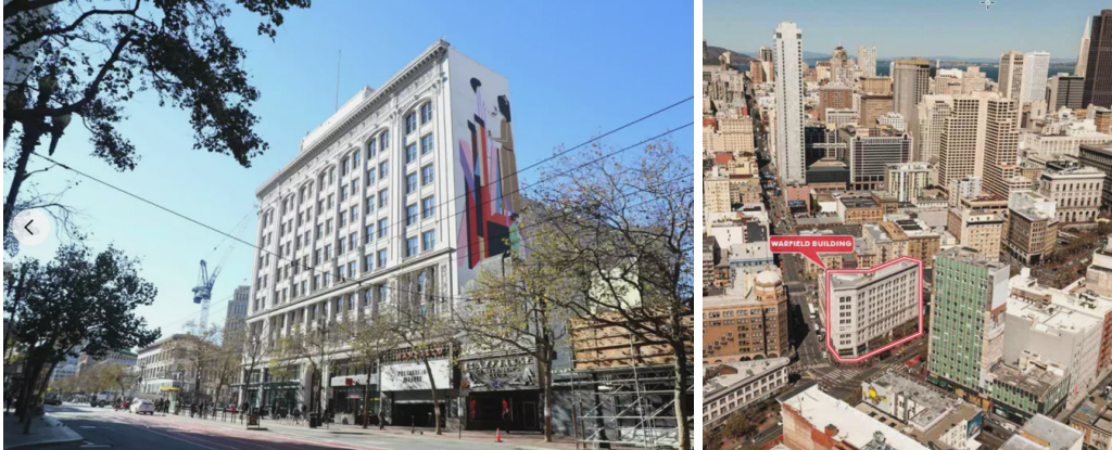
[그림 2] 주거 용도 전환 예정인 샌프란시스코 도심 소재 와필드 사무용 건물
