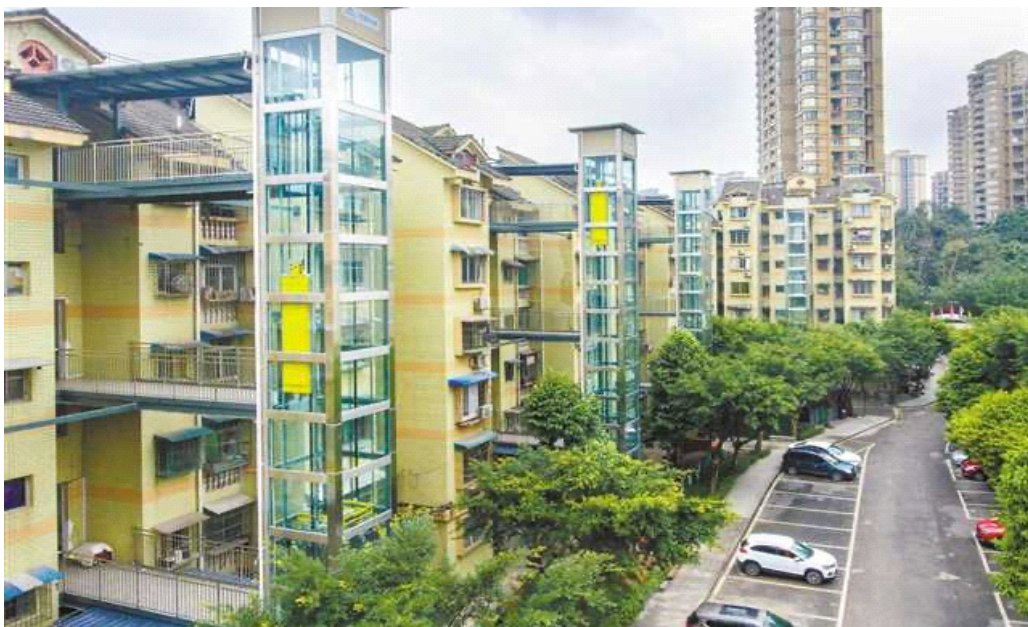
[사진] '옛 주택가 개조사업'에 따라 새로 엘리베이터를 설치한 아파트단지 (출처: 충칭일보)
