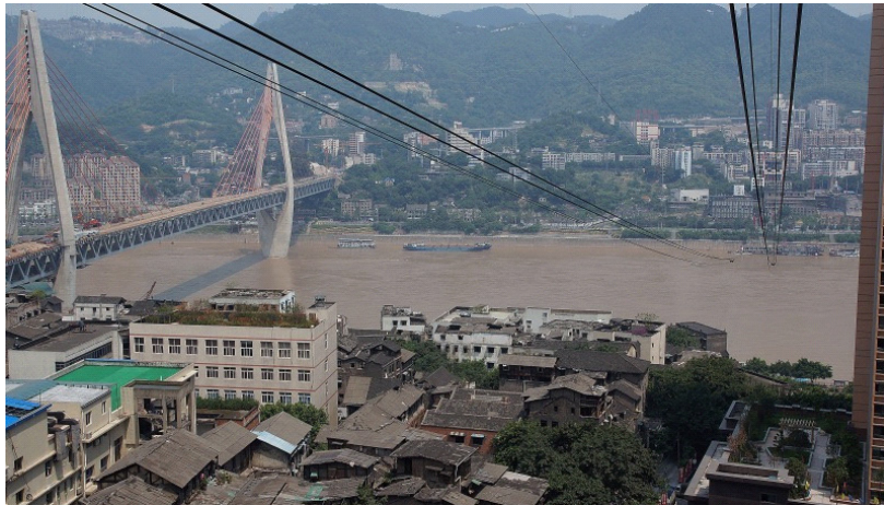
[그림] 장강 케이블카와 바로 옆에 건설된 동수문 대교 (출처: 필자 직접 촬영)
