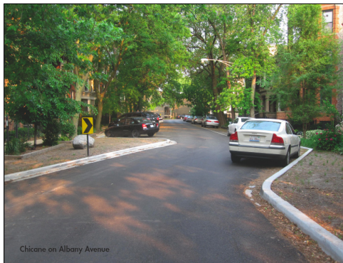
【주거지역에서의 규정속도를 줄이기 위한 도로설계안(왼쪽). 실제 운행속도를 운전자에게 알려줌으로써 속도 저감을 유도하는 방안(오른쪽)】
