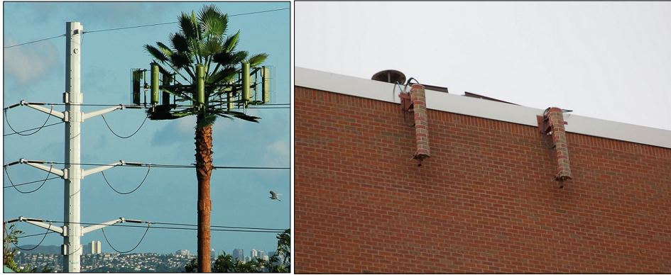
【야자수 나무의 외관을 닮은 안테나(왼쪽), 벽돌 소재 외관으로 안테나의 모습이 드러나지 않도록 한 모습(오른쪽)】
