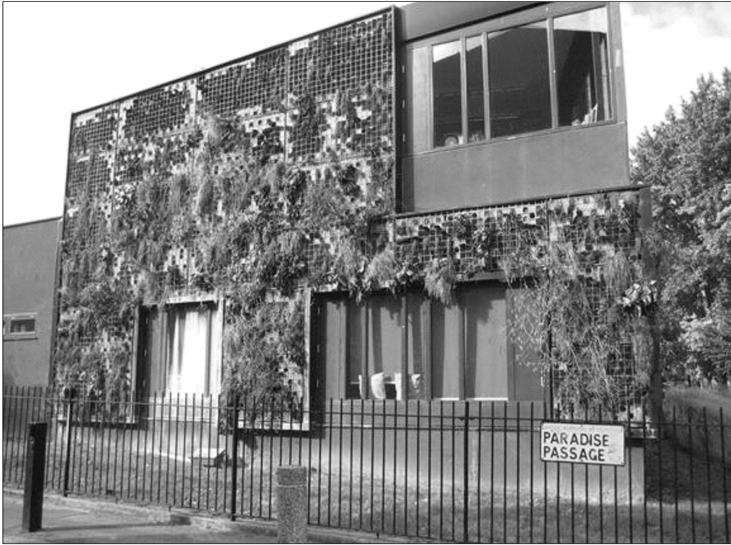
런던 Holloway Centre에 설치한 녹화벽의 식물이 말라죽은 모습
