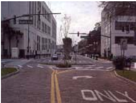
<그림 4> 차량의 통행을 제한하는 Forced Turn Island와 Full Closure
