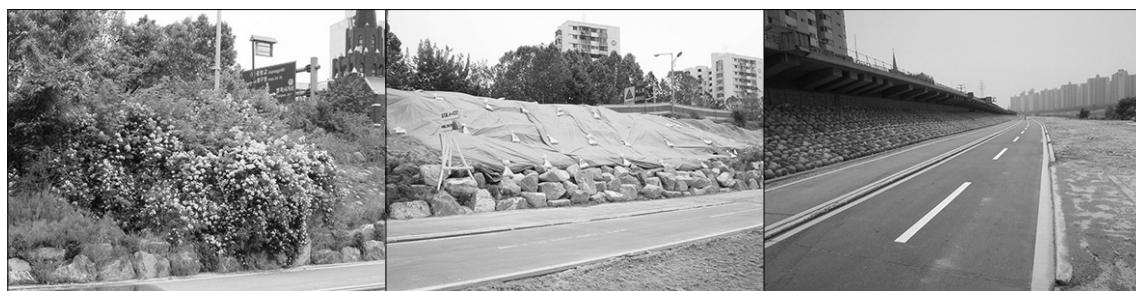
〈그림 2.10〉 석축공사 전, 중, 후의 모습
