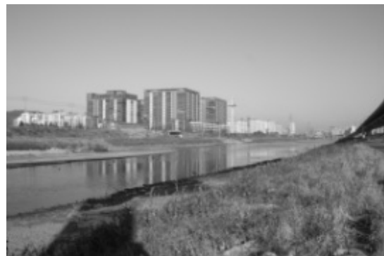
〈그림 2.16〉 기아대교-철산대교 구간 전경
