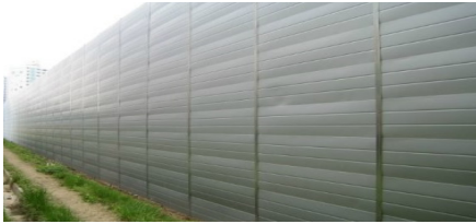
그림 4-8 가설 방음벽(설치 예)
