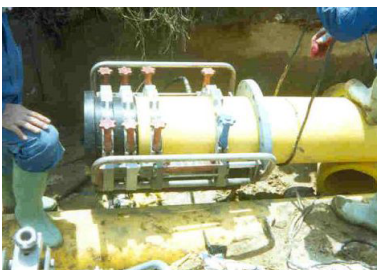
염소배관 보수작업 중
