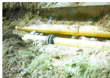
염소배관 보수작업 완료
