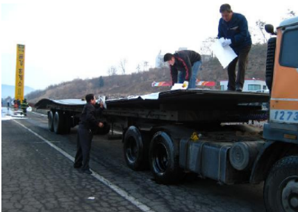
추돌차량 및 유출위험물 제거 작업
