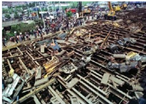
〈그림 2-12〉 대구 상인동 지하철 공사장 폭발사고
