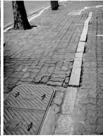
〈그림 4-84〉 보도블록의 불량시공으로 인한 안전성 미흡
