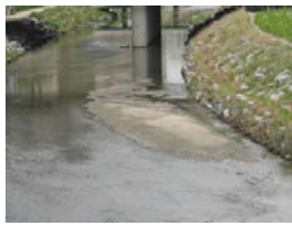
〈그림 IV-5〉 지천 합류부 낙차공 및 하상미지형 형성
