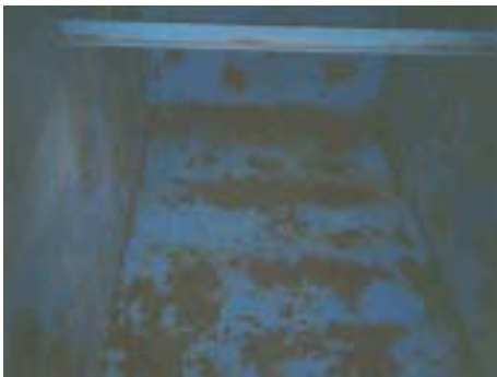
<그림 3-27> 강재저수조의 내부부식 상태
