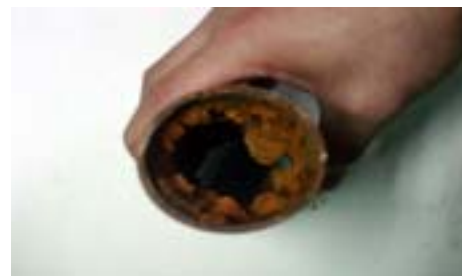
<그림 3-48> 통수년수 17년인 건물의 공동구역 입상관 내부 상태
