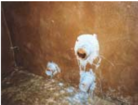
<그림 3-31> 콘크리트저수조 내부 상태
