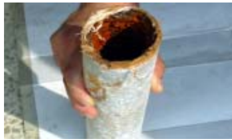
<그림 3-42> 통수년수 11년인 건물의 공동구역 입상관 내부 상태
