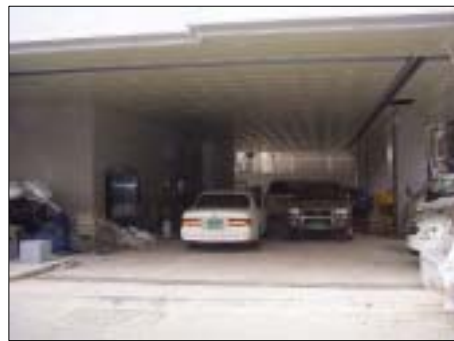
주차장 및 주차출입구 (사진㉗)
