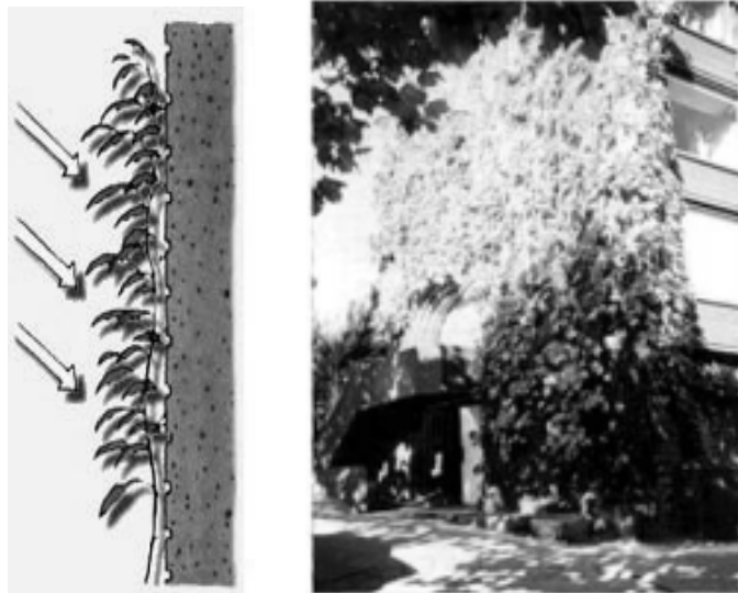
<그림 5.13> 벽면녹화 설치
