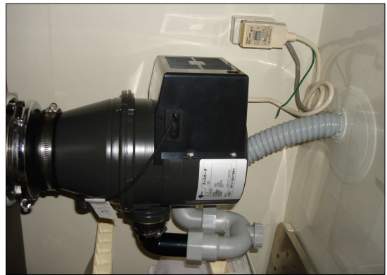
음식폐기물 분쇄기를 설치한 단독주택 싱크대에 설치된 음식폐기물 분쇄기(좌측이 상부)
