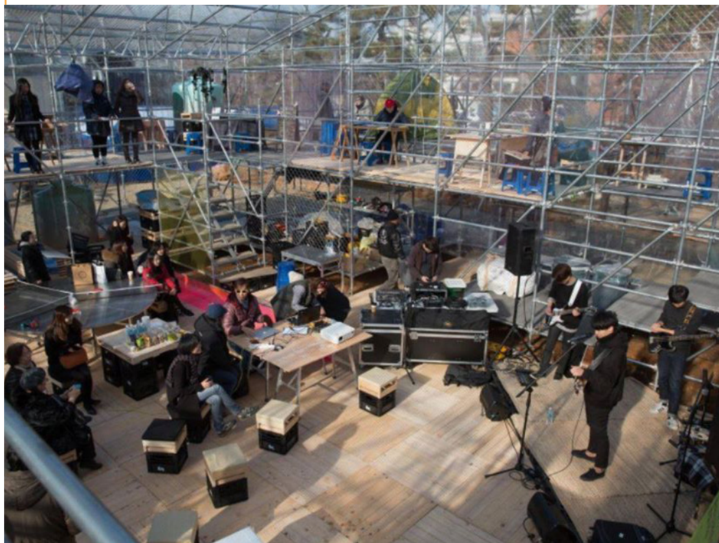
옥상에서 직접 비계구조를 설치하는 모습과 서울혁신파크에 비계구조를 이용해 설치한 전봇대집. 사진: 동대문 옥상낙원
