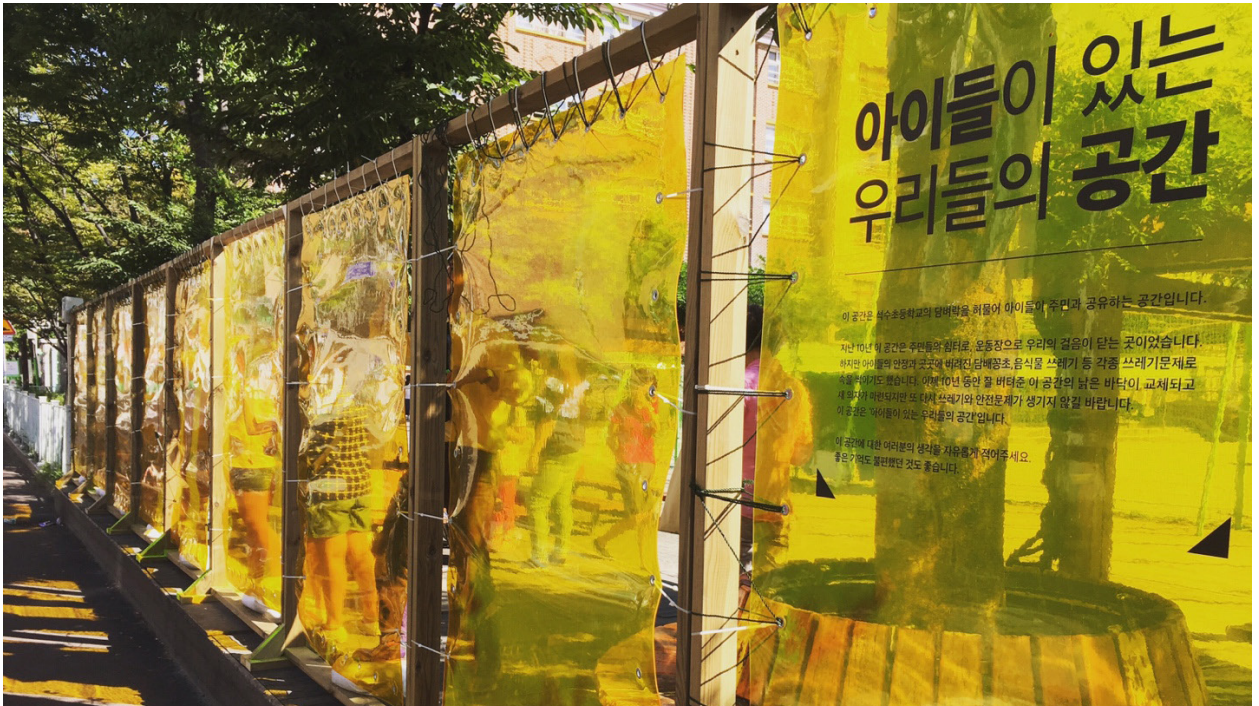
석수초등학교는 담장 허물기를 통해 주민과 다가서는 공간이 되고자 했다. 그런데 담장이 없어진 학교 가장자리에는 이내 빈 술병들과 담배꽂초들이 난무하기 시작했다. 아이들의 안전이 위협받지 않으면서도 주민들에게 열린 공간이 되기 위해 담장을 다시 세우기보다는, 젤리장은 학생들의 마음이 담긴 메세지 보드를 설치함으로써 이해관계자들 간의 소통 활동을 개척해보았다. 노랑색 PVC매트는 정육점 냉창고 가림막으로 흔히 사용되는 재료를 응용한 것. 사진: 젤리장
