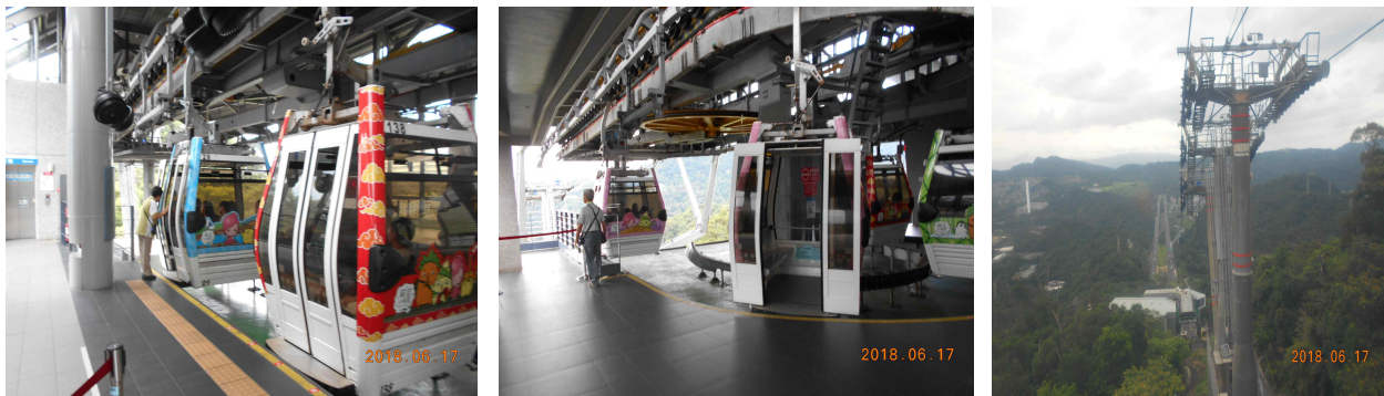
[그림 3] 마오콩 곤돌라 승강장 및 운행 현황
