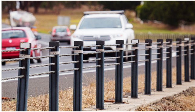
빅토리아주 도로에 설치된 연성장벽
