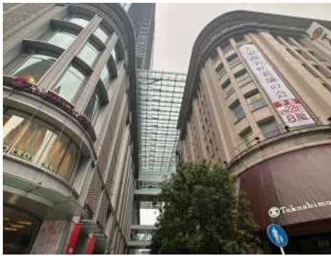
그림 33 니혼바시 갤러리아 유리 덮개 지붕
