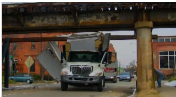
〈적재 높이를 제대로 인식하지 못해 발생한 교량과 트럭의 충돌사고 모습〉
