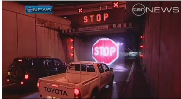
〈터널 입구에 설치된 레이저를 이용한 가상 신호시스템〉
