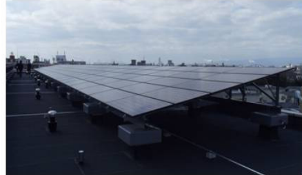
에너지 발전 설비: 태양광발전 시스템
