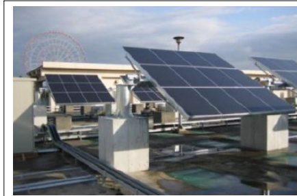
하수도 시설 내에 태양광 발전 패널 설치
