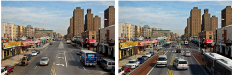
동쪽 167번街的 기존 도로(좌)와 SBS가 설치되어 개선된 도로(우)
