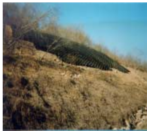
〈사진 3-2〉 난지도 매립지 사면(노출쓰레기 및 Geo Cell) 현황
