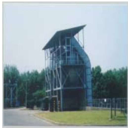
〈사진 3-8〉 난지하수중계펌프장 협잡물 처리 호퍼(Hopper)
